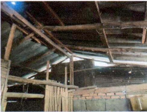
สภาพภายในบ้าน หลังคารั่วผุพัง โครงสร้างหลังคาไม่แข็งแรง ประตูไม่แข็งแรง
